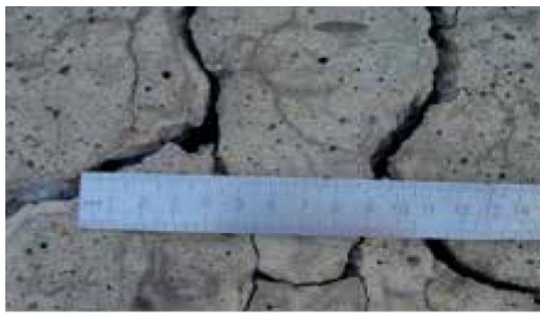
Рис. 2. Дефекты и разрушения железобетонных шпал
